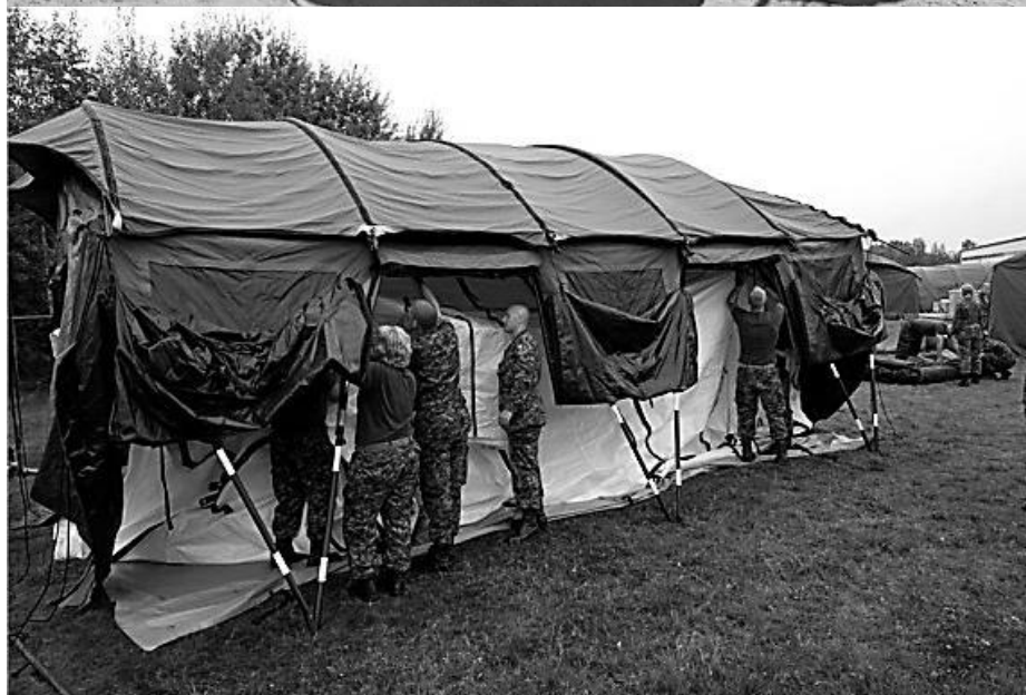
شکل ۸-۴: نحوه برپاسازی یک پناهگاه غشایی نوع صحرائی
